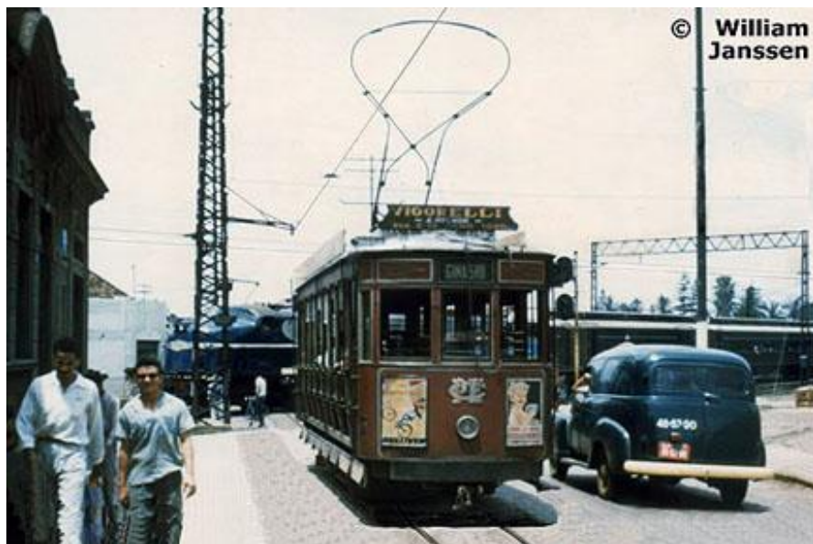
Figura 1.12: Esta é uma foto muito rara mostrando a antológica passagem de nível em São Carlos onde os bondes elétricos da Companhia Paulista de Eletricidade cruzavam a linha eletrificada da Companhia Paulista de Estradas de Ferro. Note-se que não há linha aérea para alimentar o bonde no ponto exato do cruzamento das linhas. Isso não era possível, pois enquanto o bonde era alimentado com corrente contínua de 600 volts, as locomotivas da Paulista necessitavam de corrente contínua de 3000 volts. Segundo Allen Morrison, em seu livro The Tramways of Brazil - A 120 Year Survey , o motoneiro tinha de abaixar o coletor de eletricidade do bonde e ligá-lo numa tomada usando um cabo apropriado. Após o cruzamento da linha férrea o motoneiro devia desligar o cabo e retomar o contato do coletor com a rede aérea do outro lado da linha. Esta foto foi tirada por William Jansen, provavelmente no final da década de 1950. Esta cópia é cortesia de Allen Morrison.
