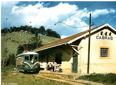
Figura 14.6: Felizmente o Ramal Férreo Campineiro durou o suficiente para que algumas fotografias coloridas registrassem seus últimos tempos de operação. Esta rara foto mostra a estação terminal de Cabras, a 32 quilômetros do ponto inicial da ferrovia, a estação de Campinas da Companhia Paulista de Estradas de Ferro. O bonde #2, visto aqui, foi adquirido de segunda mão do sistema de bondes de Belo Horizonte, logo após a E.F. Sorocabana ter assumido as operações do Ramal Férreo Campineiro. Note-se que o bonde apresenta o emblema e a cor verde típicos da E.F. Sorocabana, ao invés da pintura vermelha e amarela que caracterizava os bondes de Campinas. À esquerda da foto podem ser vistos fios de contato, mas aparentemente os trilhos por eles servidos já haviam sido retirados, o que demonstra a decadência da linha. À direita pode-se notar um cabo que conecta os fios de contato com o prédio da estação, onde certamente haveria uma subestação retificadora que energizava as linhas de contato. Foto de autoria de W.C. Janssen tirada em 1958; esta cópia é cortesia de Allen Morrison, que a publicou numa versão branco-e-preto em seu livro The Tramways of Brazil - A 130 Year Survey .
