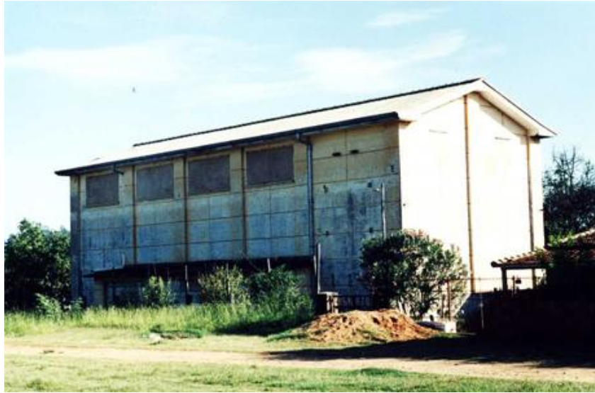
Figura 1.19: Este prédio, existente até hoje em Duartina (SP), foi originalmente construído para alojar uma subestação dentro do projeto de extensão da eletrificação da Companhia Paulista entre Cabrália Paulista e Tupã, que deveria ter sido executado em meados da década de 1960. É possível que esse projeto estivesse sendo executado quando se decidiu pela retificação do trecho entre Bauru e Garça, quando esta eletrificação perdeu o sentido. Foto tirada por Ricardo Frontera em janeiro de 2001.
