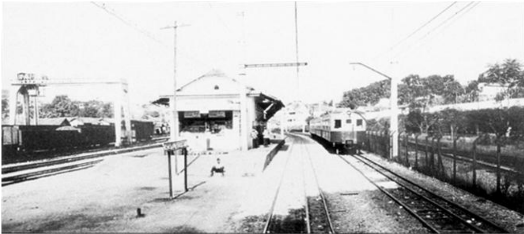
Figura 3.32: Uma rara foto mostrando um TUE Metropolitan-Cammell série 100 na estação do Horto Florestal, operando na linha Barreiro-Matadouro da E.F. Central do Brasil em Belo Horizonte, durante os anos 1960. Há registros dos horários desse serviço, ainda usando trens elétricos, na edição de Abril de 1970 do Guia Levi . Foto do Acervo RFFSA, doada por Maurício Novis Botelho e reproduzida no livro Ferrovia Centro-Atlântica: Uma Ferrovia e Suas Raízes , de José Emílio Buzelin e João Bosco Setti, editado pela Memória do Trem 99 .
