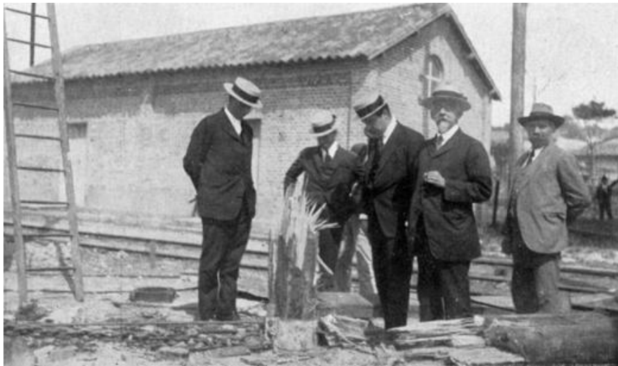
Figura 1.7: O eng. Francisco de Monlevade (o segundo da direita para a esquerda) e equipe inspecionam testes de resistência mecânica efetuados com postes de madeira a serem usados na eletrificação da linha Jundiaí-Campinas da Companhia Paulista. Foto originalmente disponível no Boletim Especial da ABEF - Associação Brasileira de Engenharia Ferroviária, In Memoriam: Francisco Paes Lemes de Monlevade, 1945.
