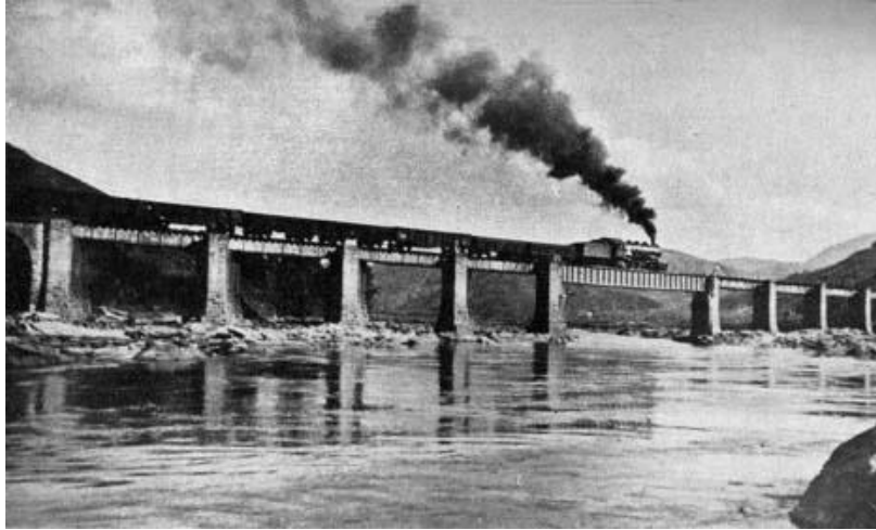
Figura 3.19: Foto da passagem do primeiro trem de minério a cruzar a Ponte do Paraíso sobre o rio Paraíba do Sul após reforma efetuada em 1943. Esta ponte tem 194 m e localiza-se no km 135,350 da Linha do Centro da EFCB próximo a Barão de Juparanã, RJ. Certamente a reforma dessa ponte também foi motivada pelo crescente tráfego de minério de ferro por essa linha. Imagem originalmente publicada em Estrada de Ferro Central do Brasil - Relatório do anno de 1943 . Cópia gentilmente cedida por Manoel Marcos Monachesi e enviada por Jorge Alves Ferreira Jr.
